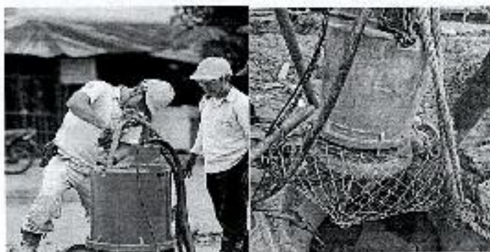
Ilustración 10. Instalación de Hidrobomba
