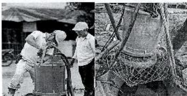
Ilustración 10. Instalación de Hidrobomba
