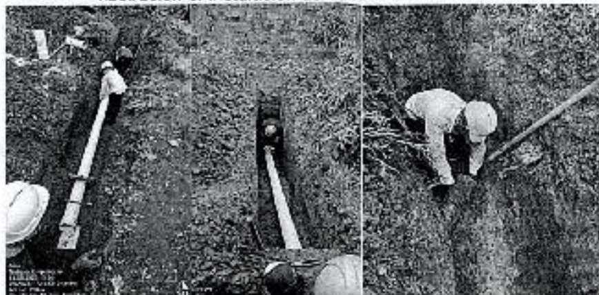
Ilustración 8. Instalación de Tubería de Acueducto
