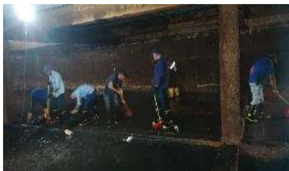
Imagen 10. Lavados de tanques semienterrados
