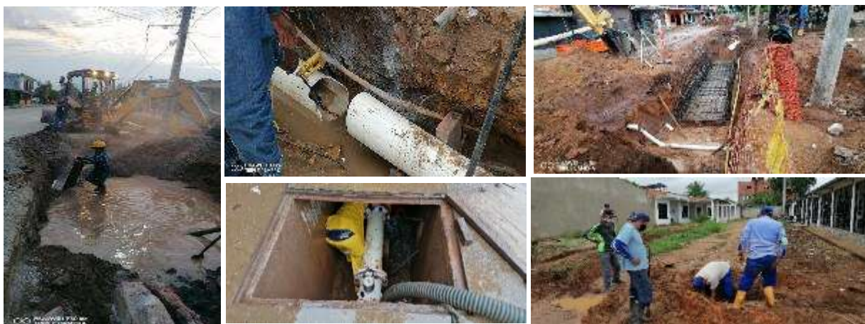
Imagen 25. Actividades de mantenimiento en red de distribución
