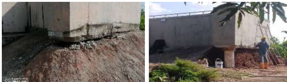
Imagen 22. Reparaciones a fisuras de tanques de almacenamiento
