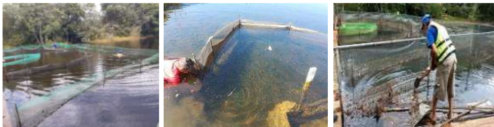
Imagen 13. Limpieza y cambio del enmallado a la entrada de la bocatoma
