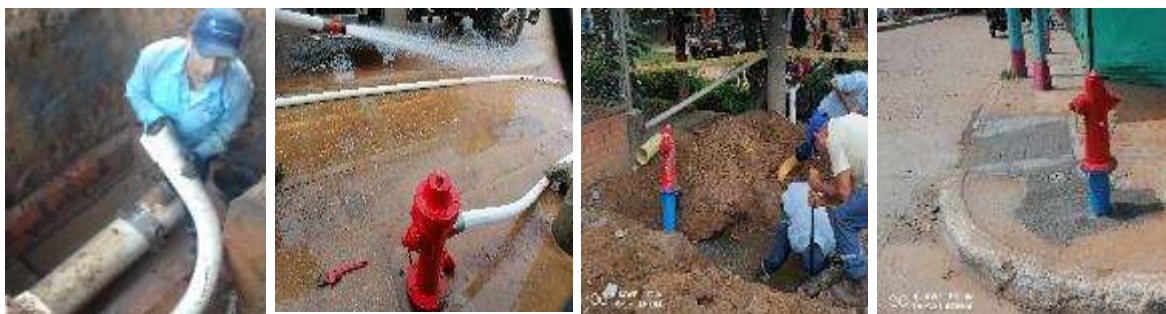
Imagen 19. Instalación de hidrantes en red de distribución
