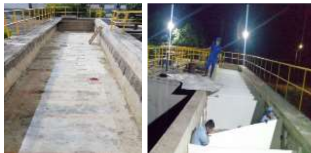
Imagen 16. Cambio de placas floculador PTAP 2
