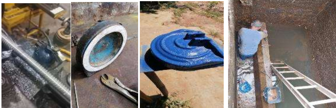
Imagen 17. Mantenimiento compuertas filtros
