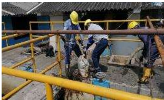
Imagen 18. Cambio de lechos filtrantes PTAP 1 y 2
