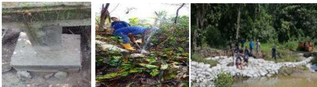
Imagen 9. Revisión de redes de aducción para diagnóstico y reparaciones
