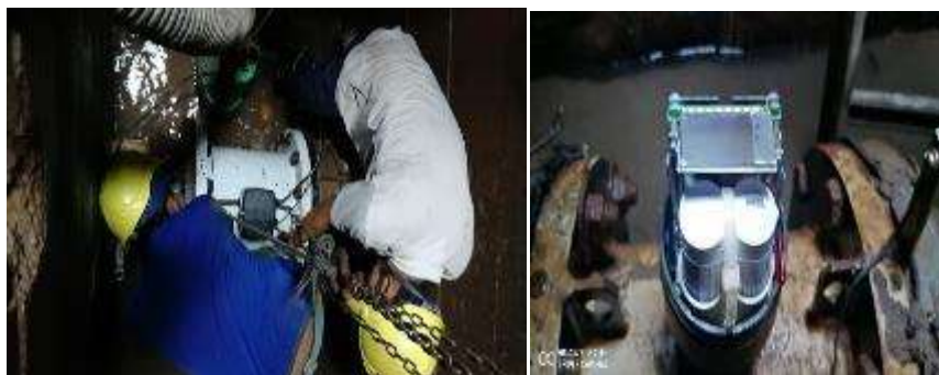
Imagen 6. Cambio de macromedidor y baterías
